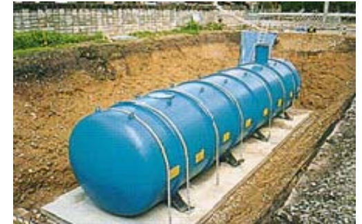
【耐震性貯水槽】
